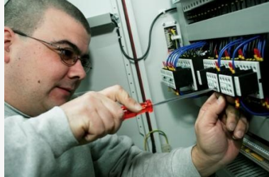
Service sur site
